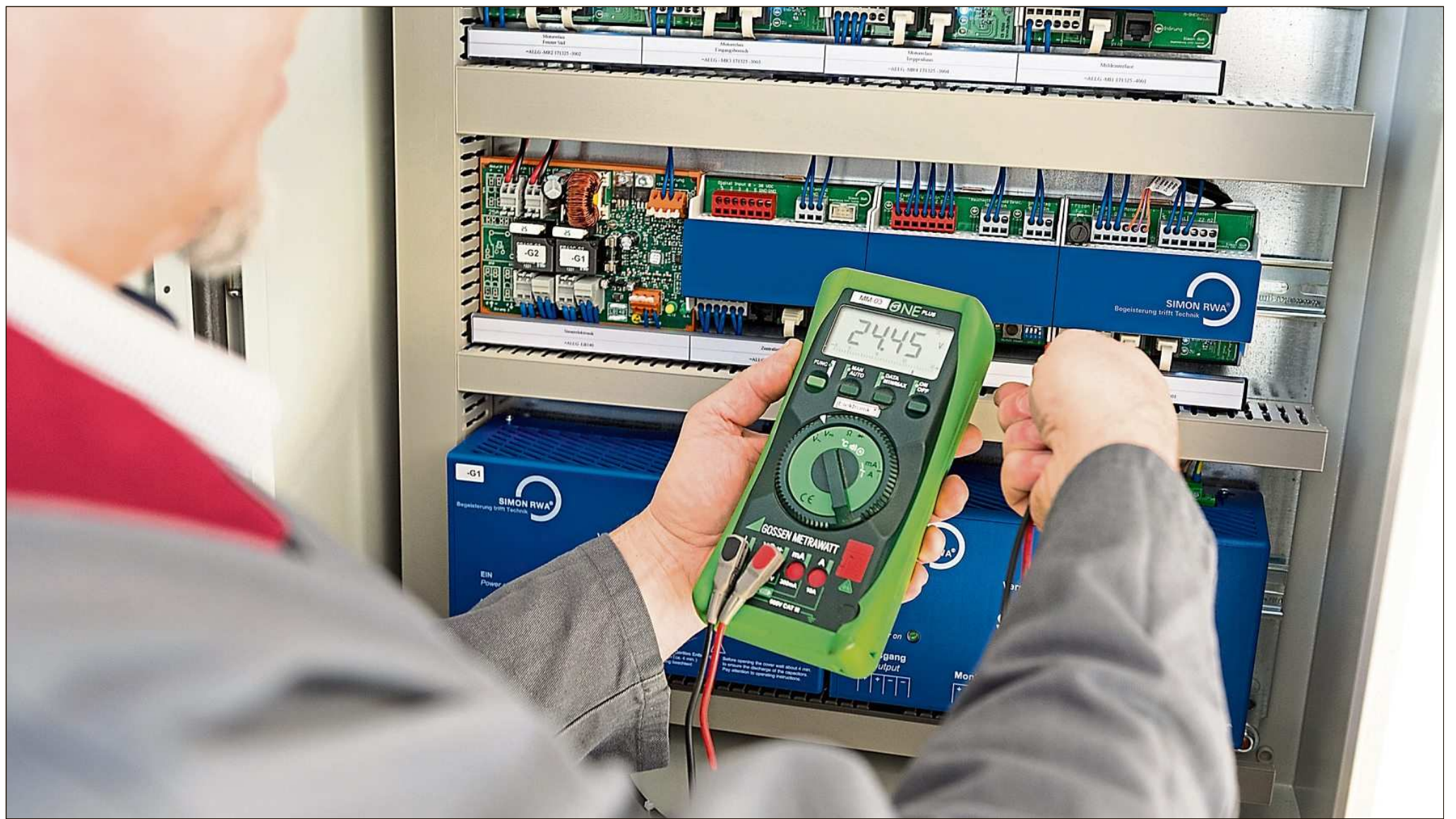
Ein Systemtechniker bei der Wartung einer Anlage.
